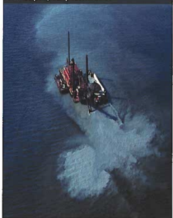
FIGUR 14.1 Foto af gravarbejde fra anlægsfasen af Ørsundforbindelsen
