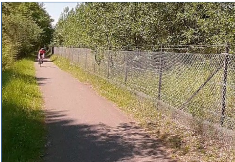
Figur 4-1. Kortudsnit fra Google Street View fra Kalvebod Sti, der viser det opsatte feltvævshegn. Det fremgår at der er 2 tråde pigtråd for oven af hegnet, og paddehegn forneden på hegnet 6 .
