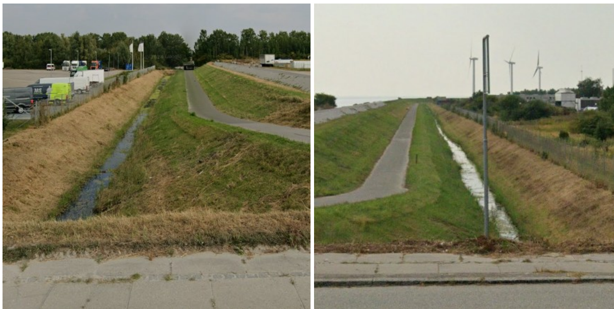
Figur 3-5. Billeder fra Google Street View. Venstre: Billede taget fra Stamholmen (set mod nord) og viser Dæmningsstien og kanalen, der løber rundt om Avedøre Holme. Cykeltunnelen ses bagerst i billedet ved træerne (Amagermotorvejen løber bag træerne). Højre: Billede taget fra Stamholmen (set mod syd) og viser Dæmningsstien og kanalen der løber rundt om Avedøre Holme.
