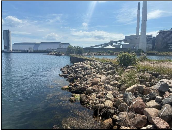
Figur 3: Kaj område – på vestsiden. Stensætning.
