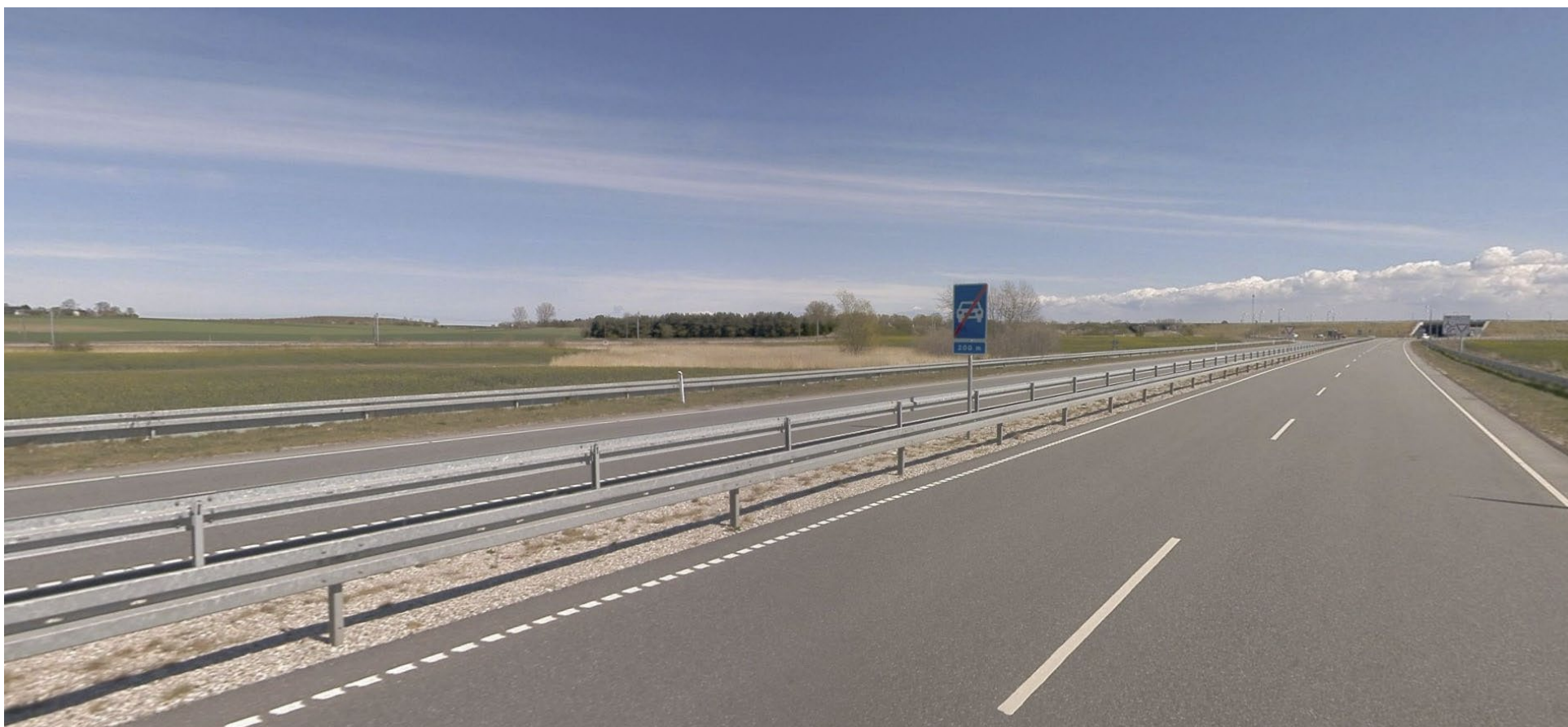
Eksisterende forhold set fra Fjordlandsvej mod nordøst. (COWI streetview).
