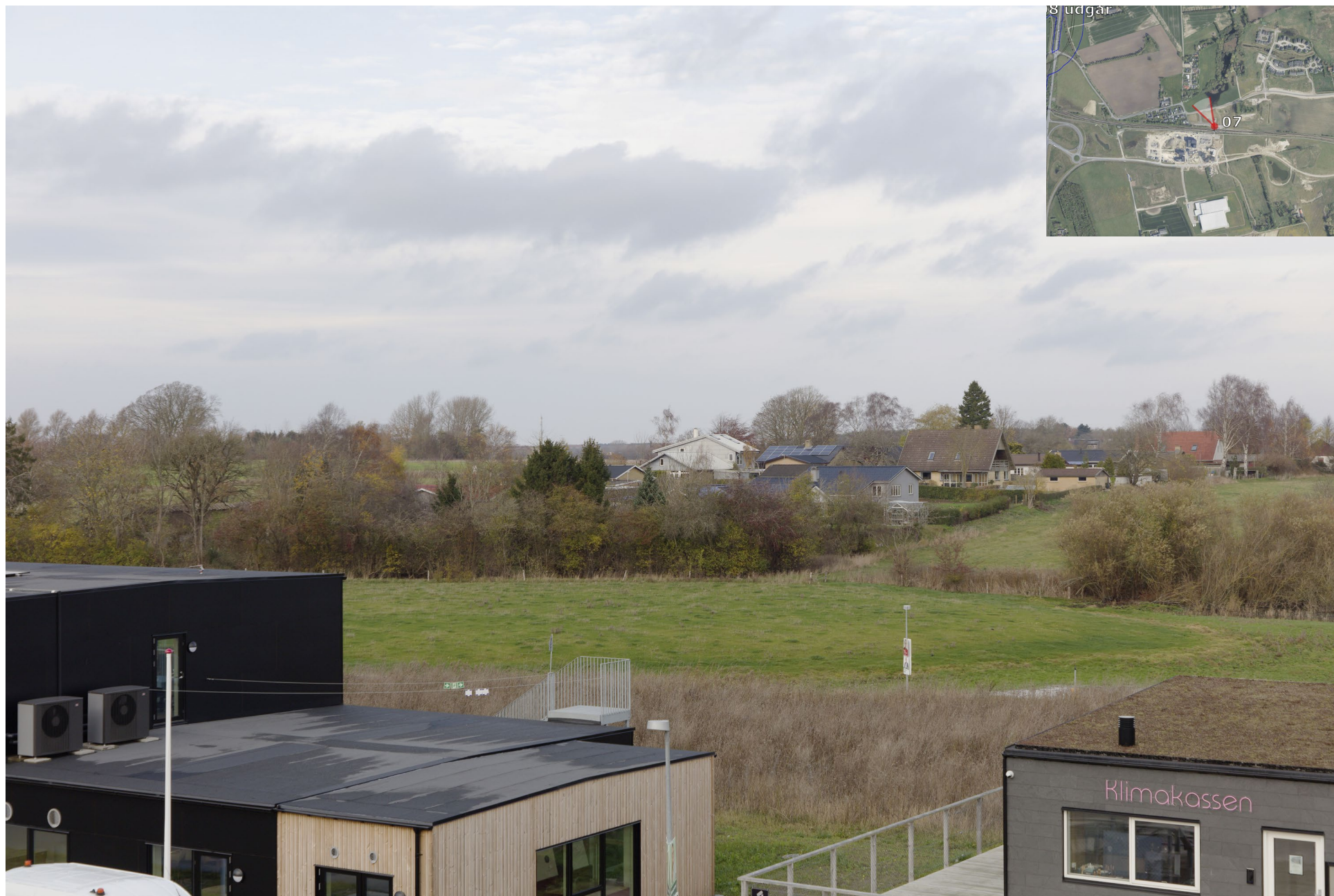
Eksisterende forhold set fra Vinge stationsbro.
