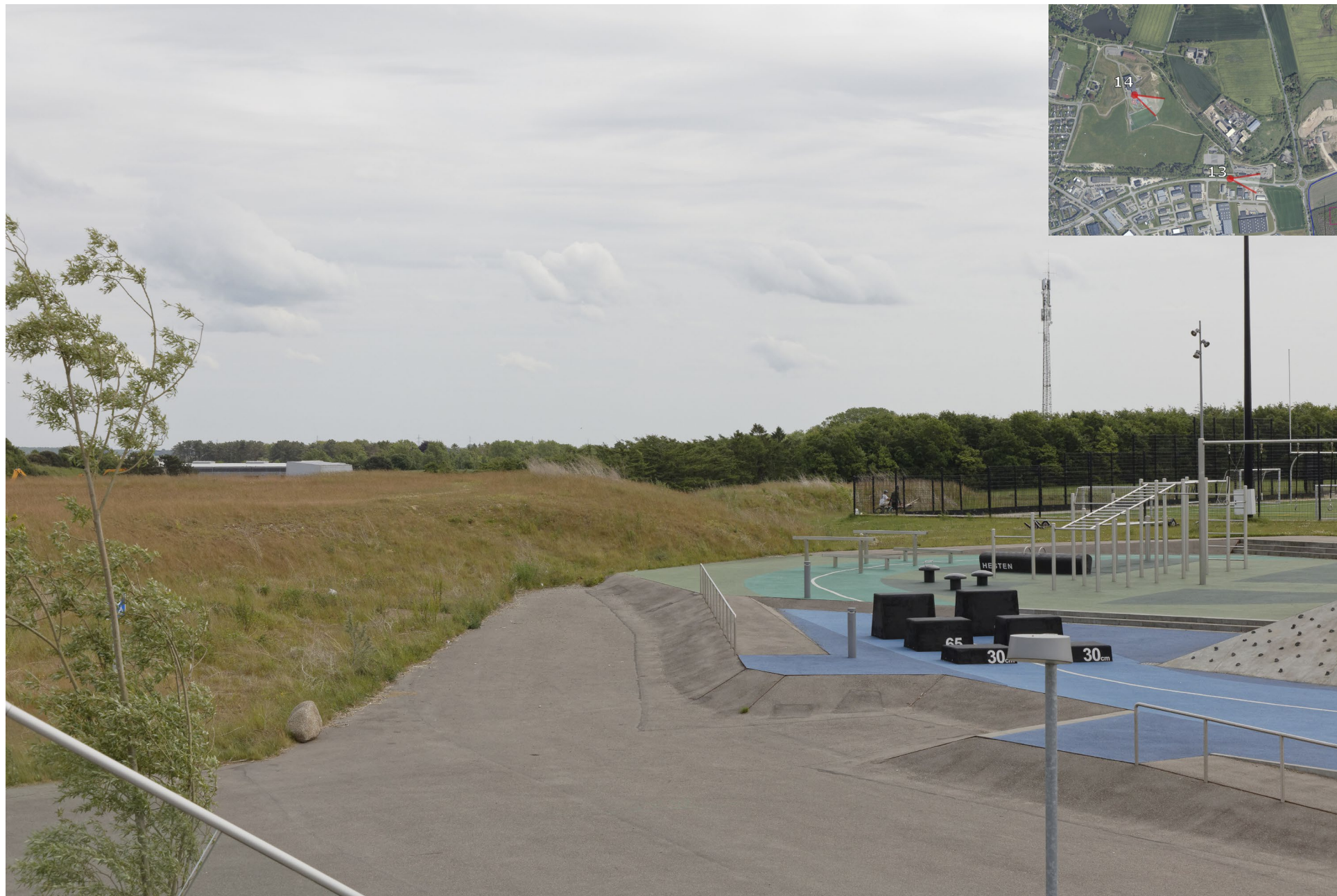
Eksisterende forhold, set fra legepladsen ved Frederikssund svømmehal.
