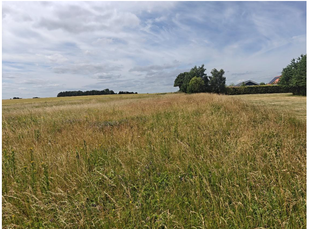
Figur 8-10 Diget BD.090.500 set fra cykelstien ved banen mod sydvest fremstår ikke synligt.
