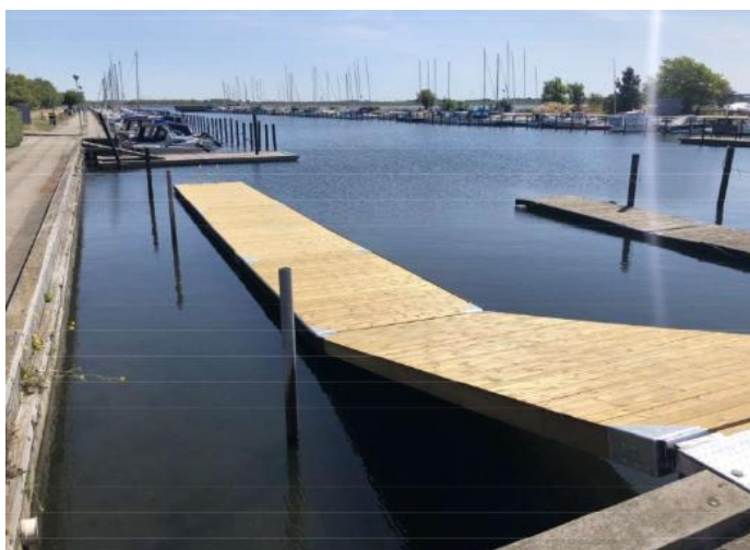
Figur 2: Et eksempel på en lignende kajak- og jolleflydebro fra leverandøren til flydebroen i Kalveboderne i Københavns Havn.
