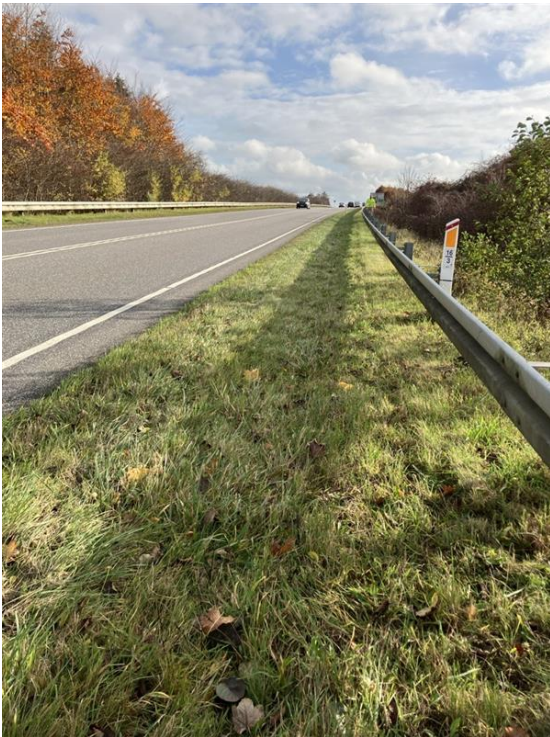
Figur 2 Den primære struktur mellem vejen og autoværnet på strækningen.
