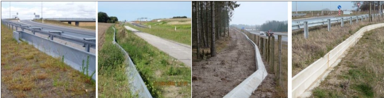
Figur 3-3 Eksempler på forskellige typer paddehegn @Vejdirektoratet.
