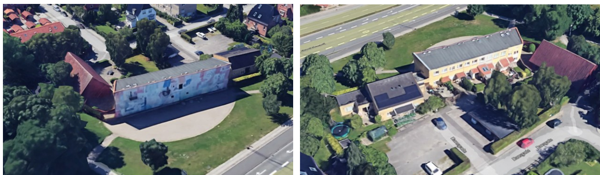
Figur 19 Billeder fra Google Earth der viser facaden mod krydset ved Skanderborgvej og den del af bygningerne, der vender mod øst og væk fra vejen. Det kan ses, at opholdsarealer og hovedparten af vinduespartierne vender væk fra vejen og det eksisterende kryds ved Skanderborgvej.
